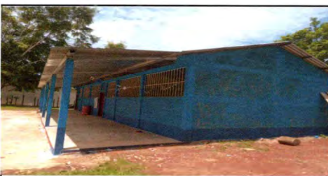
Foto 5: Vista lado oriente, paredes de madera reemplazados por pared de block, horcones.
