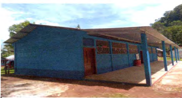
Foto 6: La habitación del corredor, horcones de concreto.
