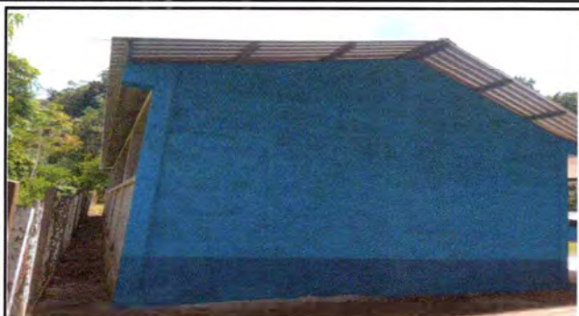
Foto 1: La paredes del lado oeste, se cambio la madera vieja, por bloc nuevos.
