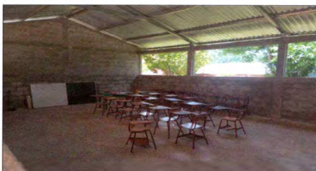
Foto 4: La laminas viejas, se cambiaron por laminas nuevas troqueladas.
